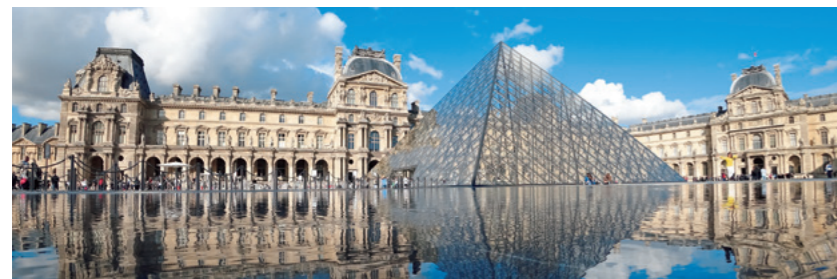
Sous l'action d'une simple source lumineuse, la photocatalyse engendre un double effet, antibuée et autonettoyant. Cette technologie a notamment été appliquée sur la verrière de la pyramide du Louvre, permettant de maintenir la transparence de l'immense surface par décomposition des impuretés.
